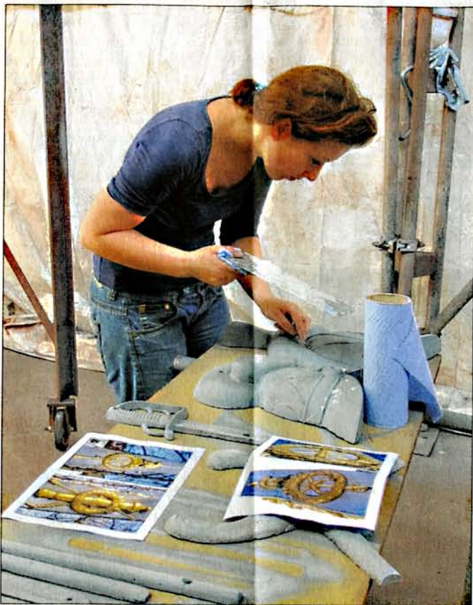
Mit Spachtel und Pinsel beseitigt die Restauratorin Bärbel Soller kleine Unebenheiten auf den Ornamenten, auf denen Gewehre, Schwerter und Helme dargestellt sind.
