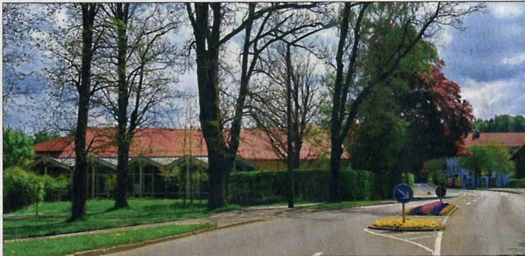
An der Salinenstraße wird in gut zwei Jahren ein neues Hotel entstehen. Es soll Salinenhöfe heißen. Die Franz-Eyrich-Halle des Traunsteiner Turnvereins wird abgerissen (Foto: Reiter)
